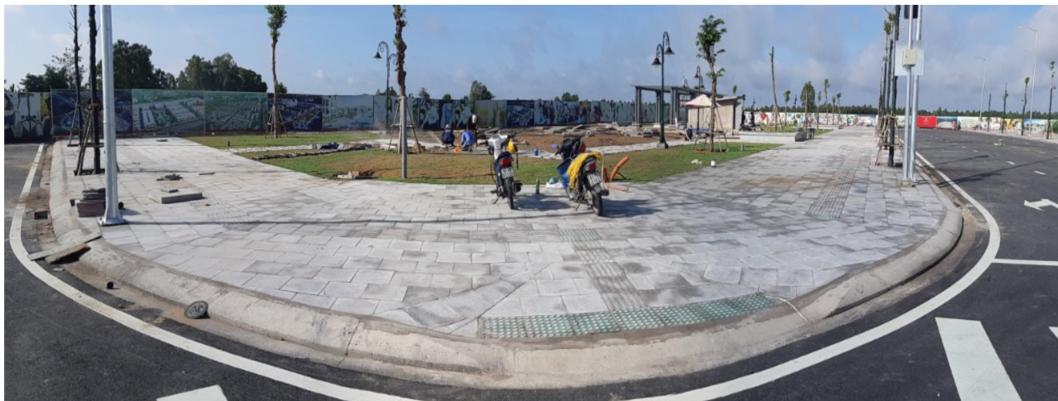
Trạm xử lý nước thải sinh hoạt thuộc Dự án Khu Đô thị Cát Tường WESTERN PEARL 2
